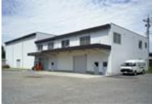
電波暗室・外観
