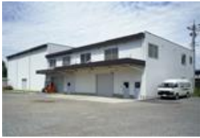
電波暗室・外観
