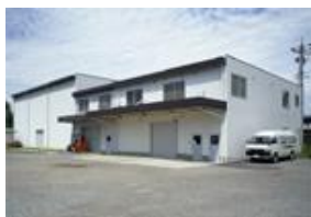
電波暗室・外観
